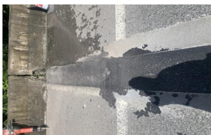
广巴段广巴向 K442+920 处伸缩缝破损修复
