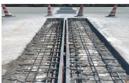
广巴段广巴向 K442+920 处伸缩缝破损修复
