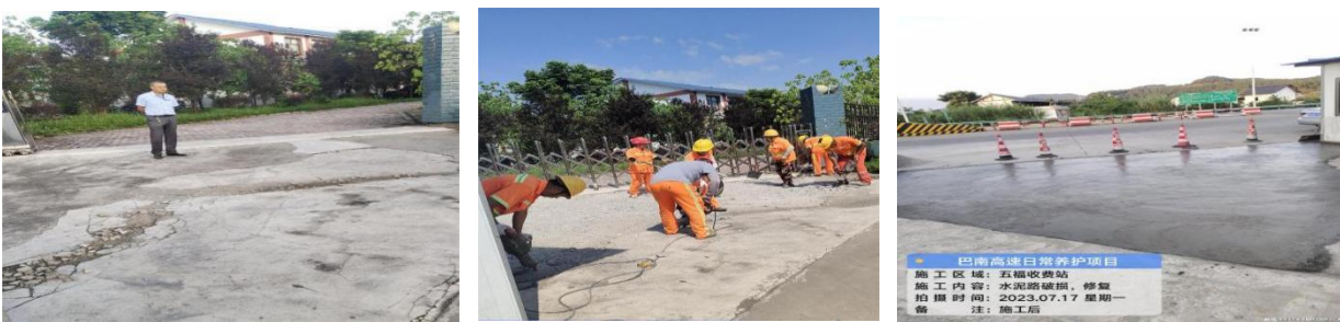
巴南段五福收费站大门口水泥地板破损修复
