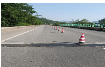
广巴段广巴向 K364+410 处伸缩缝破损修复
