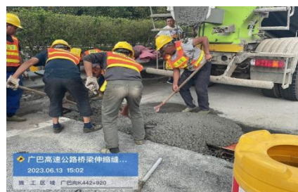
广巴段广巴向 K365+240 处伸缩缝破损修复
