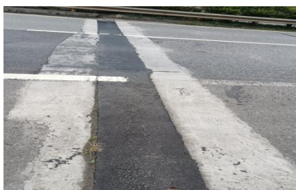
广巴段广巴向 K365+140 处伸缩缝破损修复
