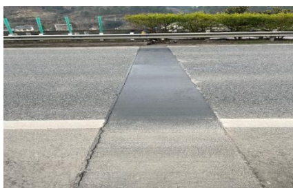
广巴段广巴向 K365+240 处伸缩缝破损修复
