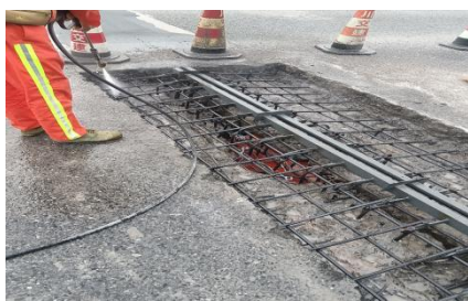
广巴段广巴向 K365+140 处伸缩缝破损修复
