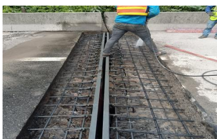
广巴段广巴向 K364+410 处伸缩缝破损修复
