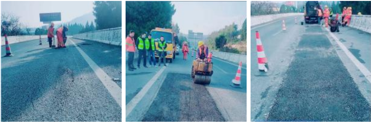
路面裂缝修复
