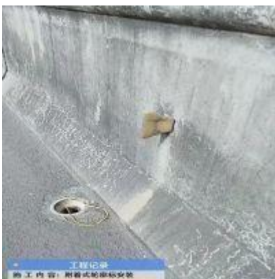
巴陕段巴中收费站匝道、K320-K324 应急车道更换附着式轮廓标
