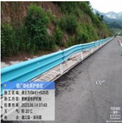
护栏板螺栓螺帽缺失更换
