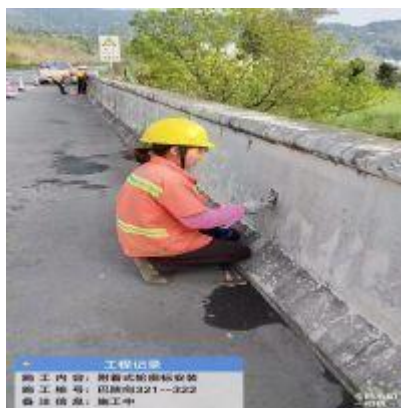
巴陕段巴中收费站匝道、K320-K324 应急车道更换附着式轮廓标
