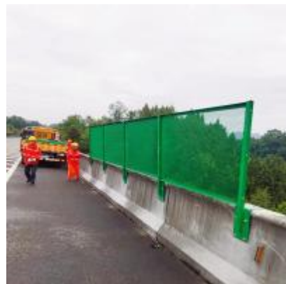
巴南段恩阳河大桥、太极图大桥、之字河一号桥、彭家坝大桥、双石大桥加装防抛网
