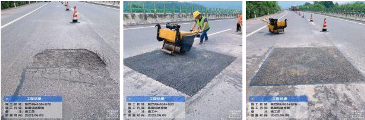
巴陕段 K310+300-K323+800、K854+500-K898+900 处路面坑洞修补
