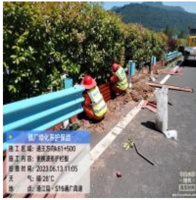
王通段通王向 K61+520 处更换护栏板
