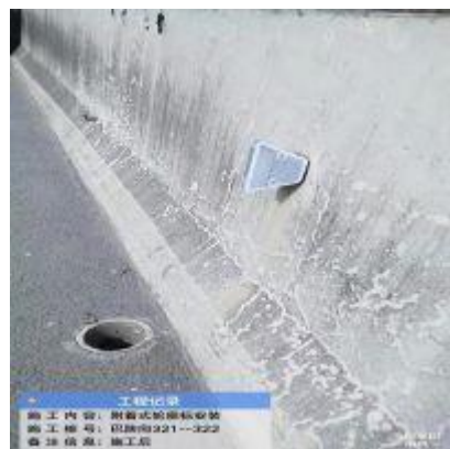
巴陕段巴中收费站匝道、K320-K324 应急车道更换附着式轮廓标
