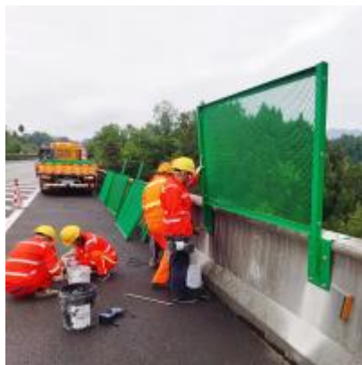
巴南段恩阳河大桥、太极图大桥、之字河一号桥、彭家坝大桥、双石大桥加装防抛网
