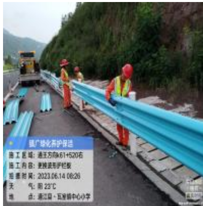
护栏板螺栓螺帽缺失更换
