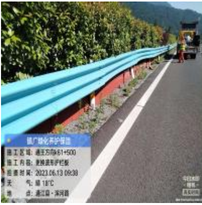
王通段通王向 K61+520 处更换护栏板
