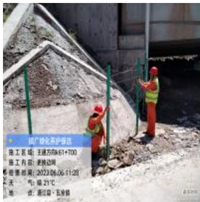
巴南段恩阳河大桥、太极图大桥、之字河一号桥、彭家坝大桥、双石大桥加装防抛网
