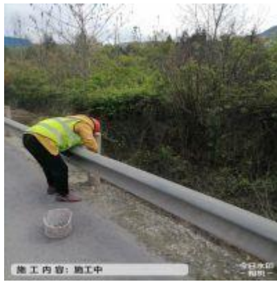
巴陕段 K310+300-K323+800、K854+500-K898+900 护栏螺栓缺失增设
