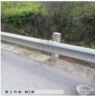
巴陕段 K310+300-K323+800、K854+500-K898+900 护栏螺栓缺失增设
