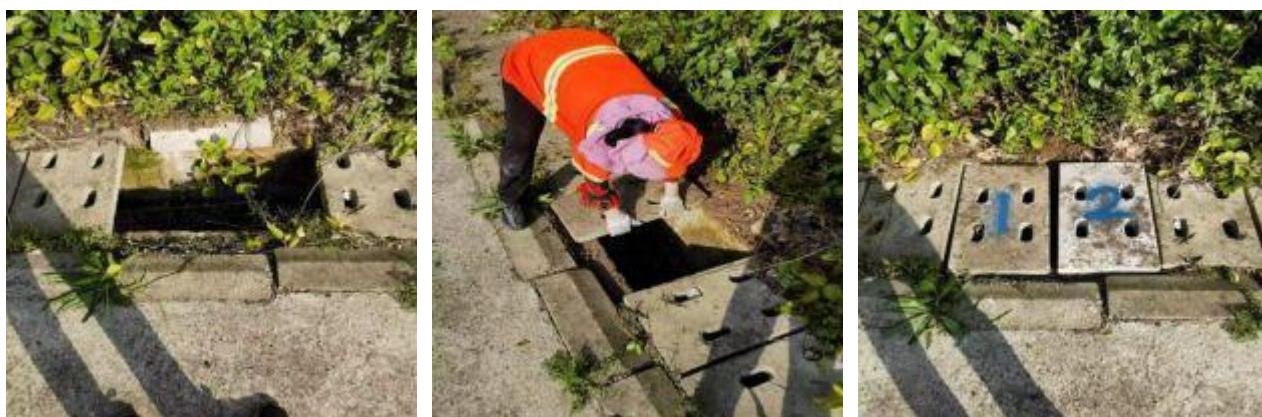
巴南段 K251+700 巴中方向安装水沟盖板
