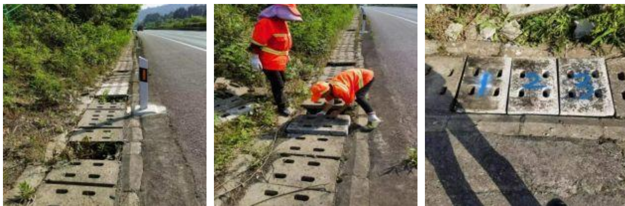
巴南段 K247+500 巴中方向安装水沟盖板
