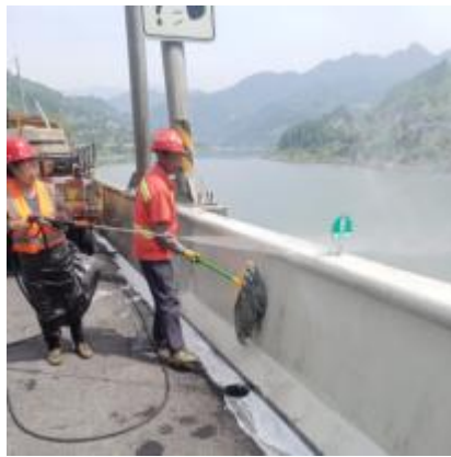
巴陕段巴陕向 826 人工清洗新泽西护栏
