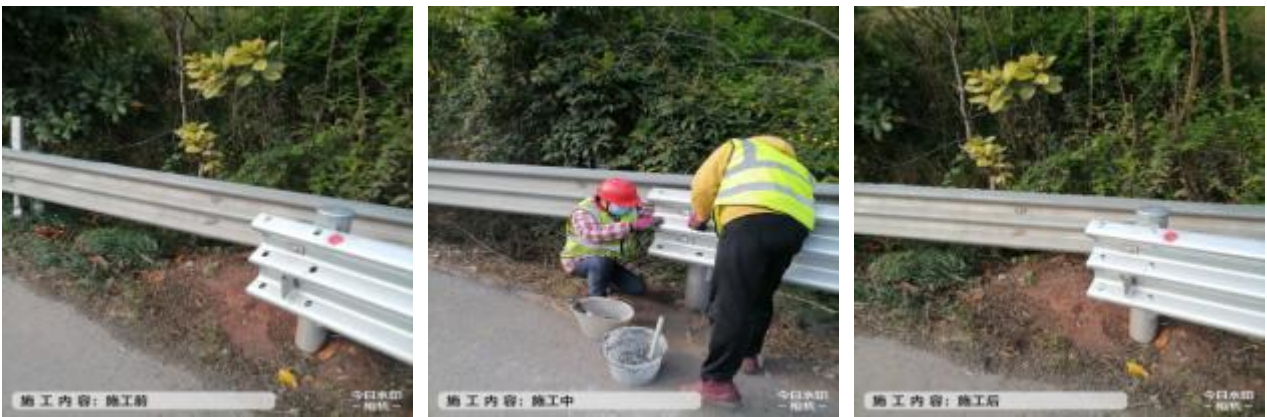
广巴段广巴向 K362+500 护栏板螺栓螺帽缺失更换
