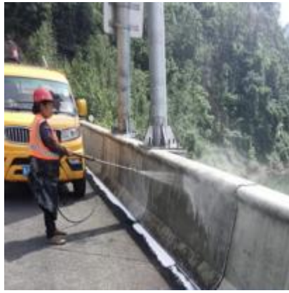
巴陕段巴陕向 828 人工清洗新泽西护栏
