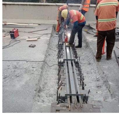
巴陕段巴陕向 825+45 处更换桥梁伸缩缝型钢
