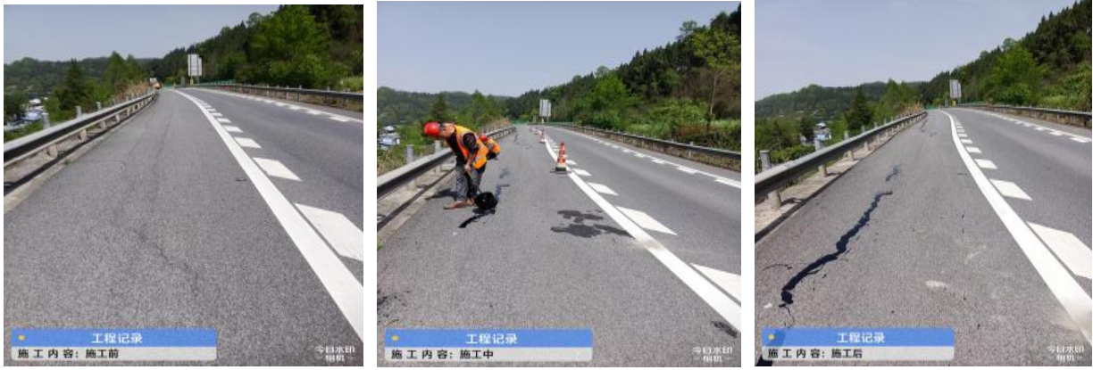
广巴段 K447-452 处路面裂缝修复
