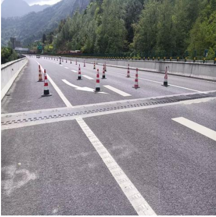
巴陕段陕巴向 827 桥梁伸缩缝焊接梳齿板
