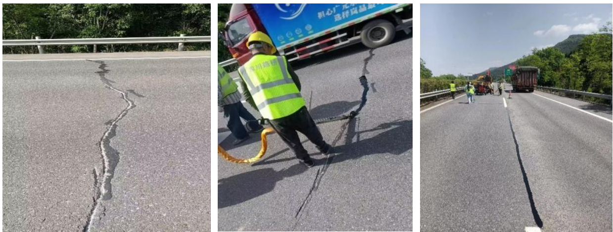
广巴段 K447-452 处路面裂缝修复
