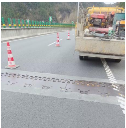
巴陕段陕巴向 830+620 处快凝混凝土找平
