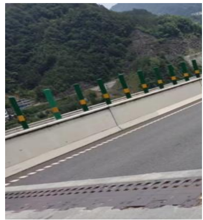
巴陕段陕巴向 816+900 桥梁伸缩缝焊接梳齿板
