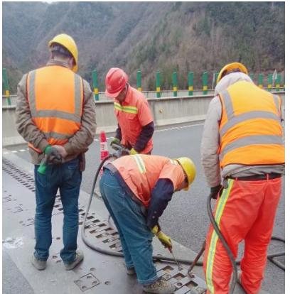
巴陕段陕巴向 830+620 处快凝混凝土找平
