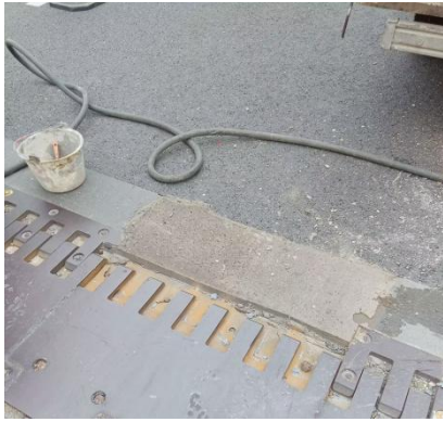
巴陕段巴陕向 825+45 处更换桥梁伸缩缝型钢
