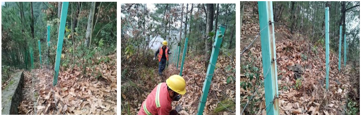
安装、更换水沟盖板
