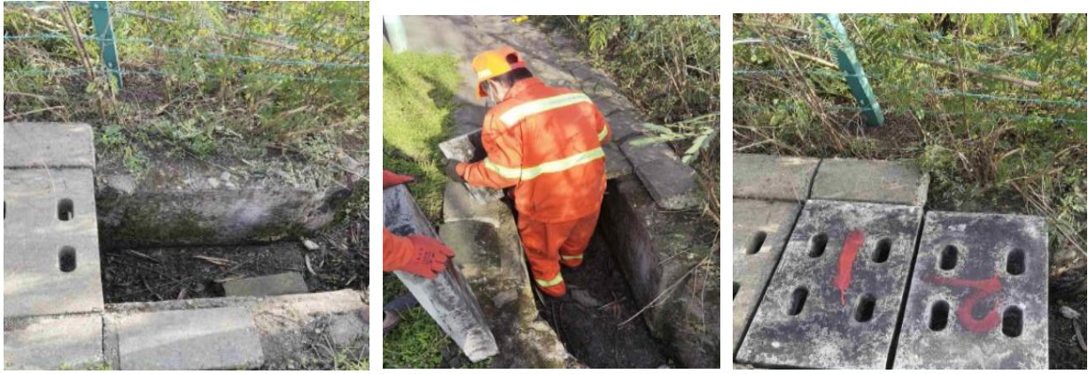
护栏板新增托架、立柱
