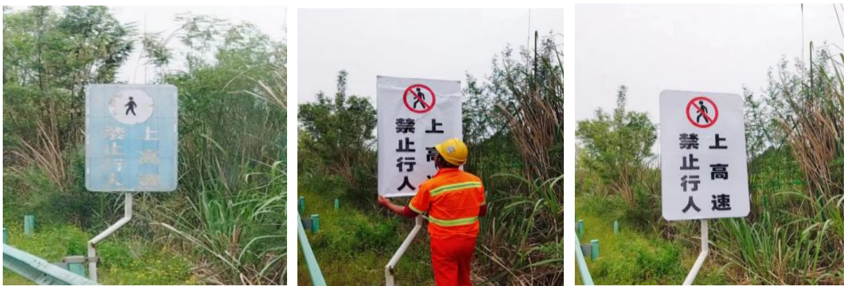
巴南段 K247+900 巴中方向更换行人上高速标志警示膜
