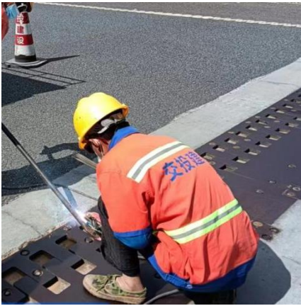
巴陕段陕巴向 816+900 桥梁伸缩缝焊接梳齿板
