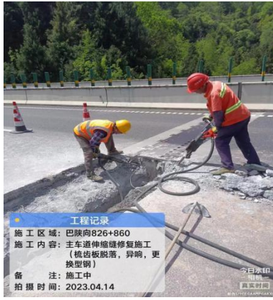
巴陕段陕巴向 827 桥梁伸缩缝焊接梳齿板
