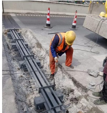
巴陕段陕巴向 830+620 处快凝混凝土找平
