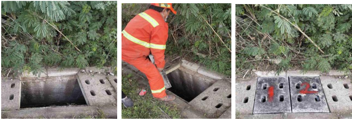
巴南段 K246+200 成都方向安装水沟盖板
