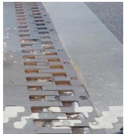
巴陕段陕巴向 812+080 处焊接桥梁伸缩缝梳齿板
