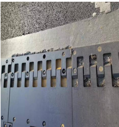
巴陕段陕巴向 812+080 处焊接桥梁伸缩缝梳齿板
