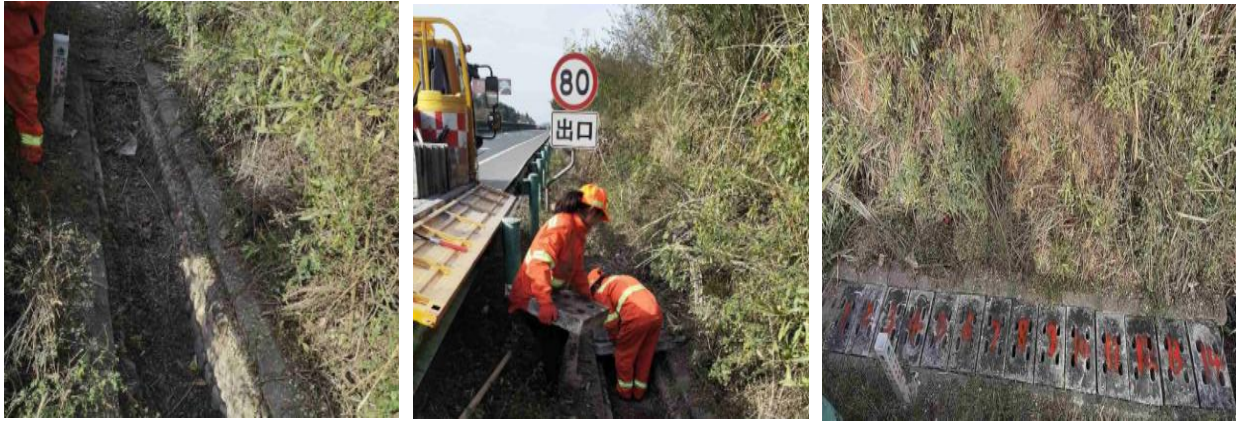
巴南段 K245+700 成都方向安装水沟盖板
