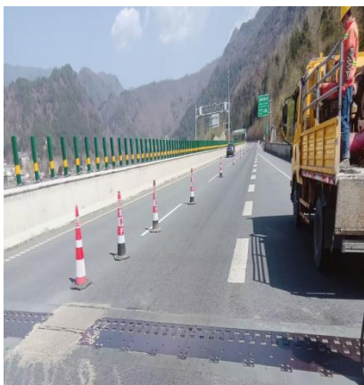
巴陕段陕巴向 830+620 处快凝混凝土找平
