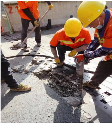
巴陕段陕巴向 816+900 桥梁伸缩缝焊接梳齿板
