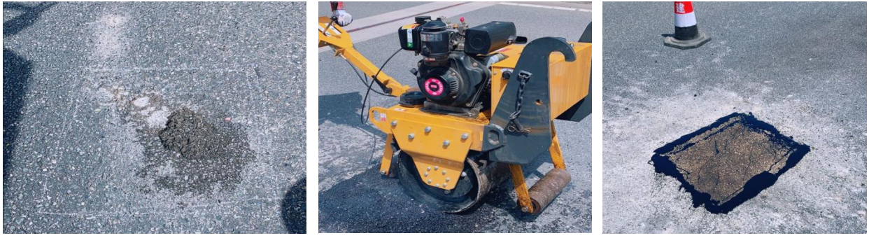
巴陕段陕巴向 851+660 处路面坑洞修补
