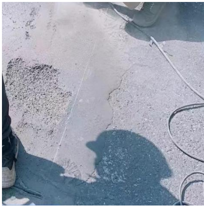
巴陕段巴陕向 841+530 处路面坑洞修补
