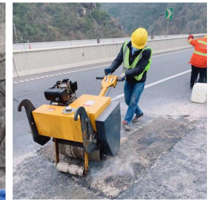
巴陕段陕巴向 841+300 处路面坑洞修补
